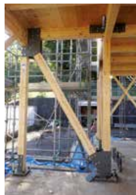
20倍壁の強度を持つブレース
