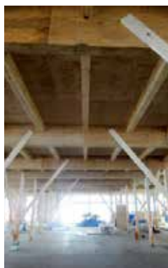
キーテック製のLVEの梁:集成材よりも剛性が高く、梁せいが小さくなる
