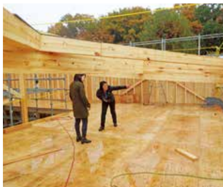
屋根の水平ブレース
