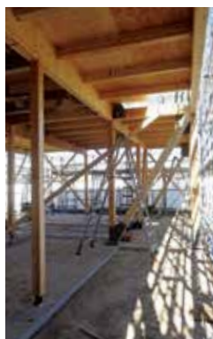
キーテック製のLVEの梁:集成材よりも剛性が高く、梁せいが小さくなる
