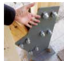
柱脚の鉄骨金物
