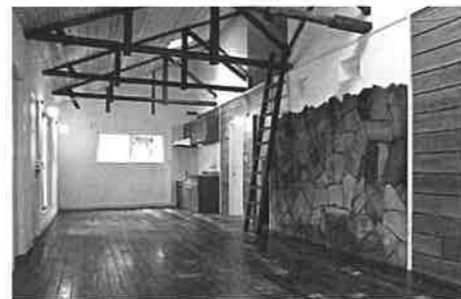
写真4 改修が終了した米軍ハウス
