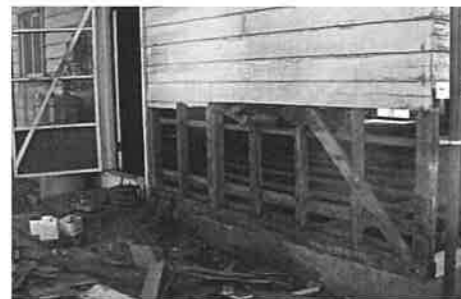
写真3 改修前の米軍ハウス
